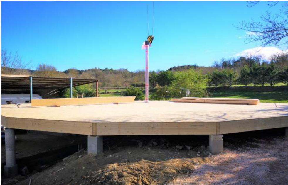
Plancher mis en œuvre sur les plots de fondations
