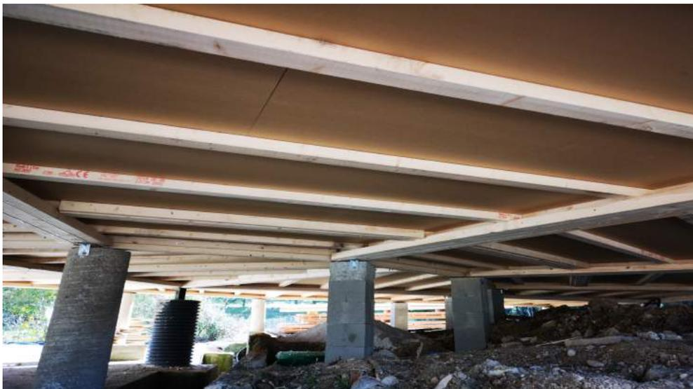
Plots ou ré-hausses de béton armé recevant le plancher
