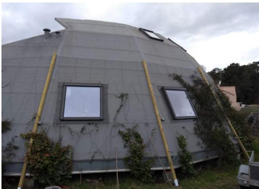
Une gouttière en zinc (en option) coure en bas de pente du dôme pour récupérer l'eau de pluie. Elle converge ensuite idéalement vers une cuve de béton enterrée, pour être utilisée à des fins sanitaires ou même pour la boire.
