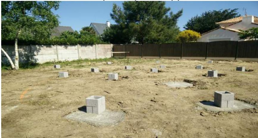
Ré-hausses en béton armé sur semelles massives en béton armé
